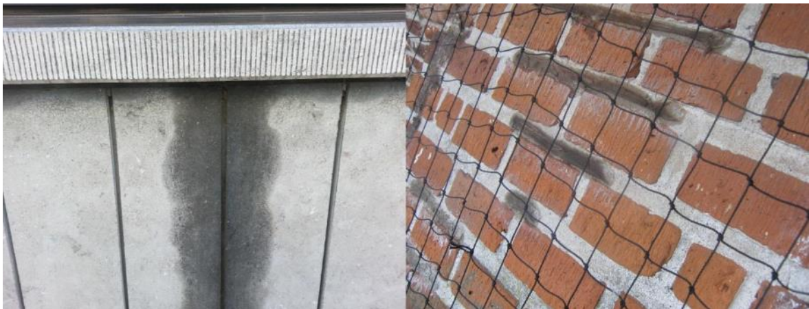
Verkleuring door weekmakers uit siliconen kit bij hardsteen (3.3.b)
