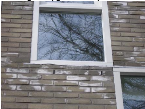
Uitbloei van oplosbare zouten (3.1.b)
