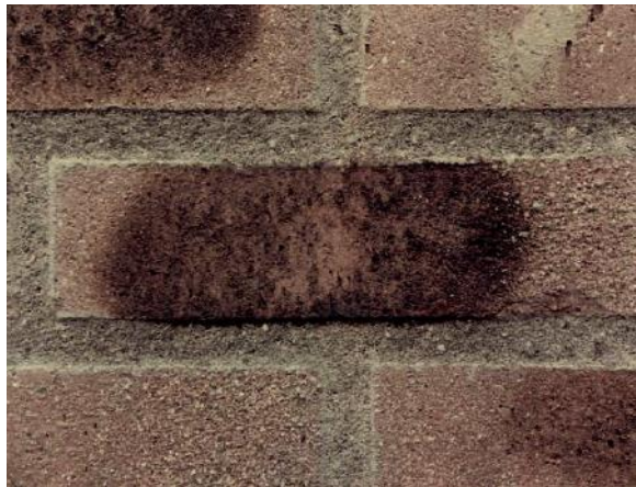
Mangaanroest op een strengperssteen (3.5.c)
