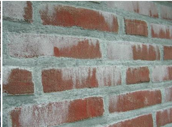
Uitspoelen van kalk uit vers voegwerk (3.1.b)
