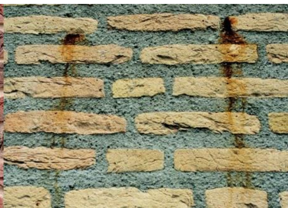
Roestende pyrietpitten in voegwerk (3.5.b)
