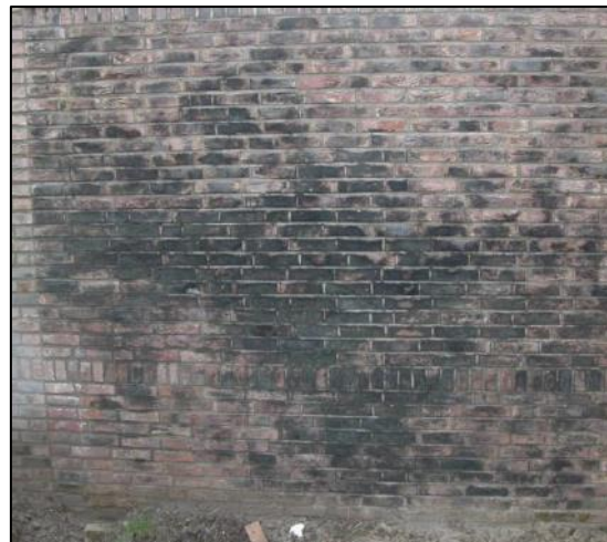
Schimmels door behandelen met suikerwater (3.3.a)
